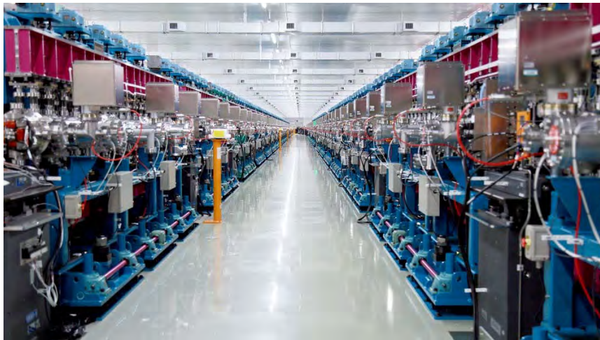
図2. SACLA のアンジュレータホール
