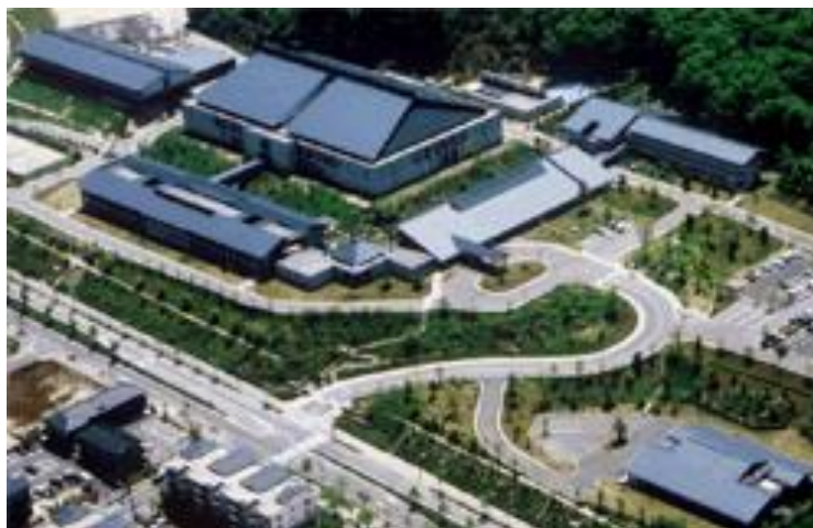
写真1 関西光科学研究所（木津地区）の全景写真（出典：HP）
