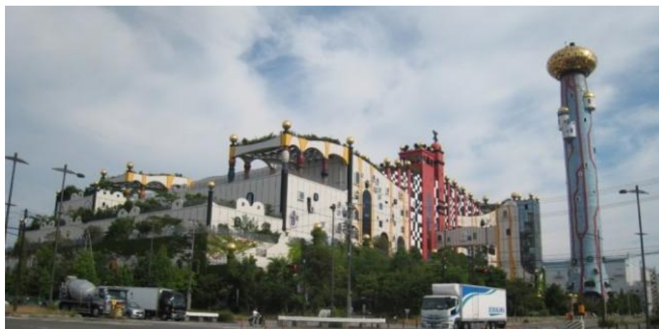
写真 1 大阪市環境局舞洲工場全景
